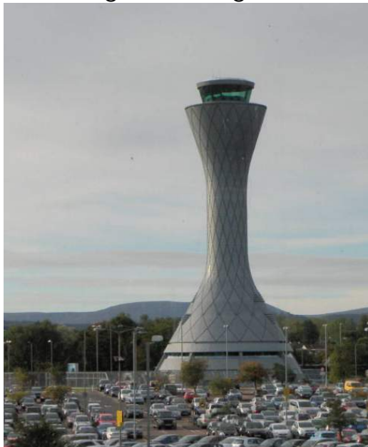
Kontrollturm am Flughafen Edinburgh
