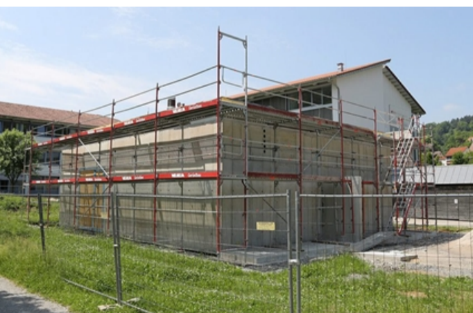
Auf dem Campus Horb entsteht ein Laborgebäude mit Kfz-Prüfstand.
